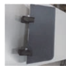
文字の切り出し、組み立て、支持具で壁に固定
