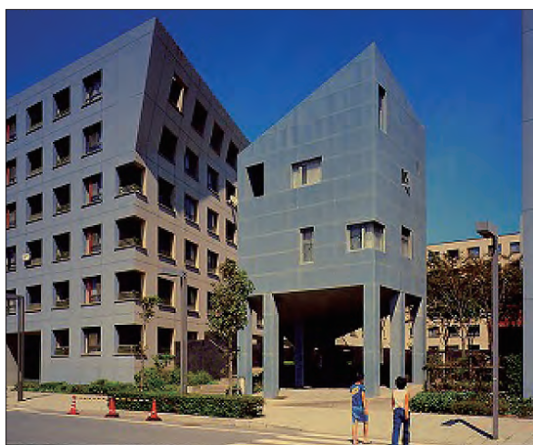
アクティブビルディング（景観先導施設）
