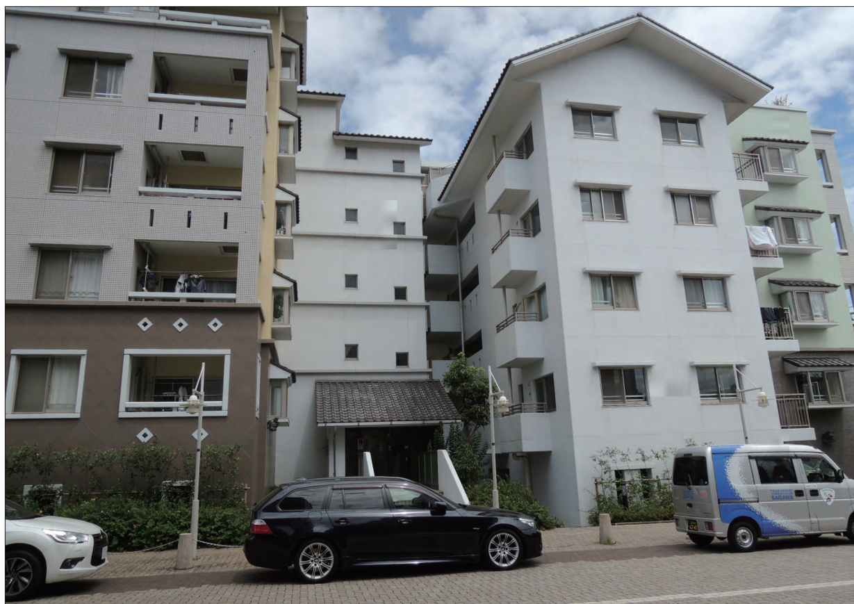
瓦屋根を持つ住棟
