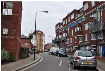
空中歩廊が撤去された街路
