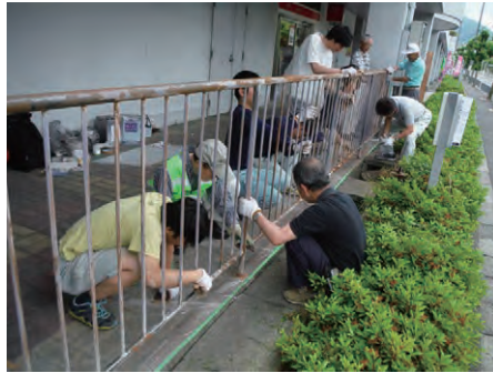
図 8. 塗ってみよう会。塗装前の下地処理作業
