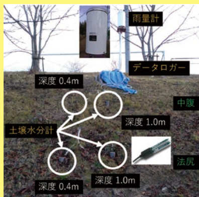
原位置計測システム（降雨浸透特性）
