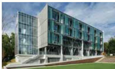
イノベーション創生センター
