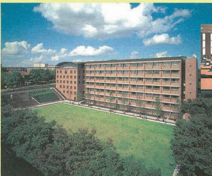
尚文館 平成12年7月竣工
