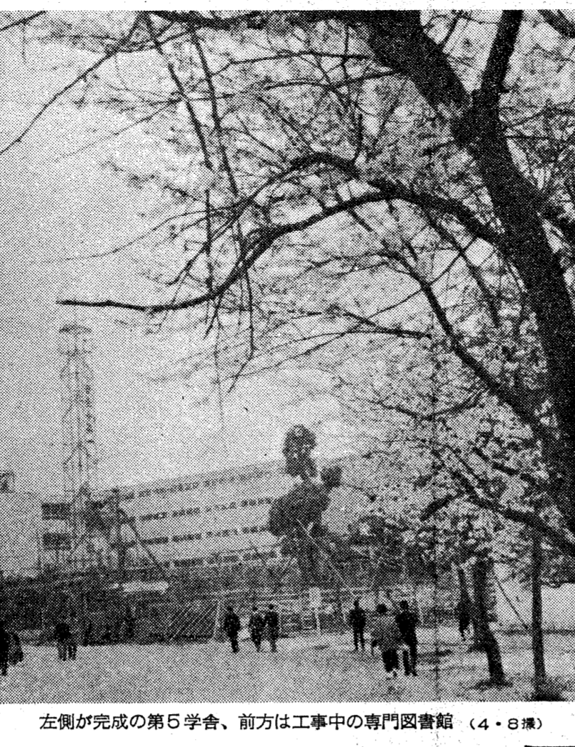
左側が完成の第5学舎、前方は工事中の専門図書館(4・8棟)
