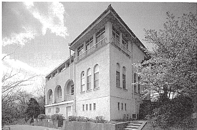
(法科大学院棟(仮称) 建築にあたり、除却することになる以文館)
