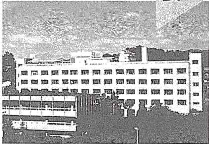
改装工事が行われる北斗寮
