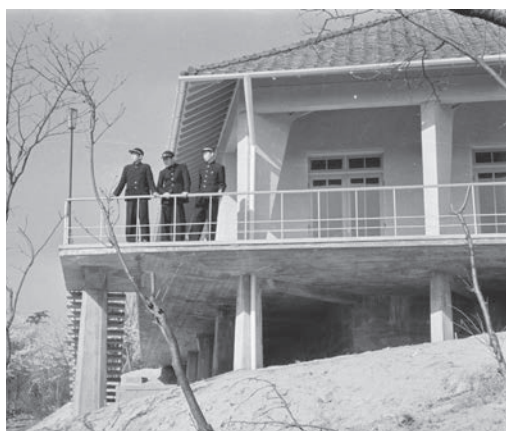
写真6 講堂兼体育館(景風館) 南面バルコニーを望む バルコニーを支える柱や階段はコンクリート打ち放し。上部構造は鉄骨造で、先細りの柱は構造的な形態がそのまま表れたもの。
