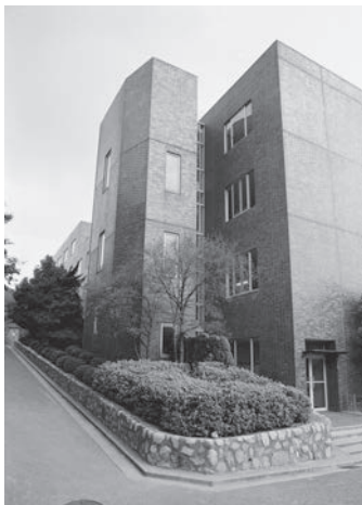
写真19 新一高校舎 北西の階段室 扁平な八角形の階段室が塔のようで、通学路の曲がり角のアクセントになっている。階段室と矩形的建物の間はガラス張りになっている。
