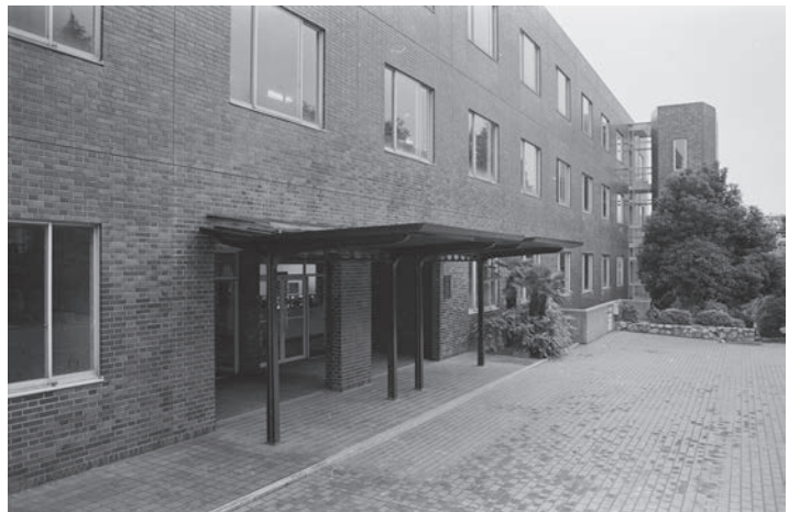
写真18 新一高校舎 正面玄関庇
