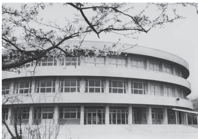
写真8 一中校舎(扇形校舎) (1957年) 南側から見ると、当時全国で建てられた円形校舎のように見える。南面にはバルコニーが設けられている。
