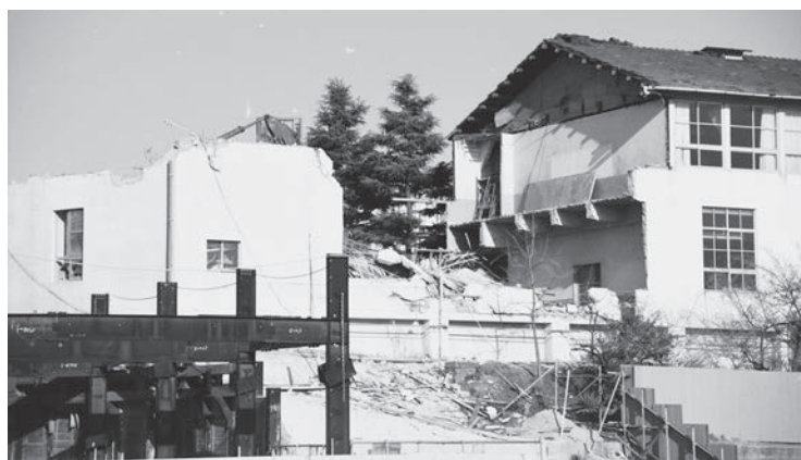
写真16 旧一高校舎 解体部分
