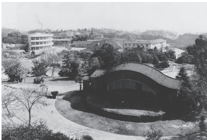
写真10 外苑北部の高台から一高・一中エリアを望む
