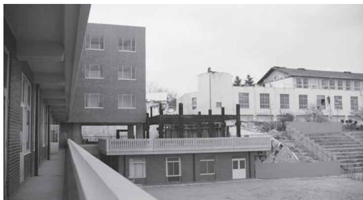
写真15 新一高校舎（第1期竣工部分）から東を望む 2期工事の鉄骨の組み立てが進むと同時に、旧校舎北側部分が解体されている。
