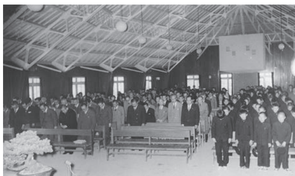
写真7 講堂兼体育館(景風館) 内部 天井はなく、屋根を支える鉄骨造のトラス構造がそのまま表れている。1957年11月に行われた、扇形校舎落成式の様子。
