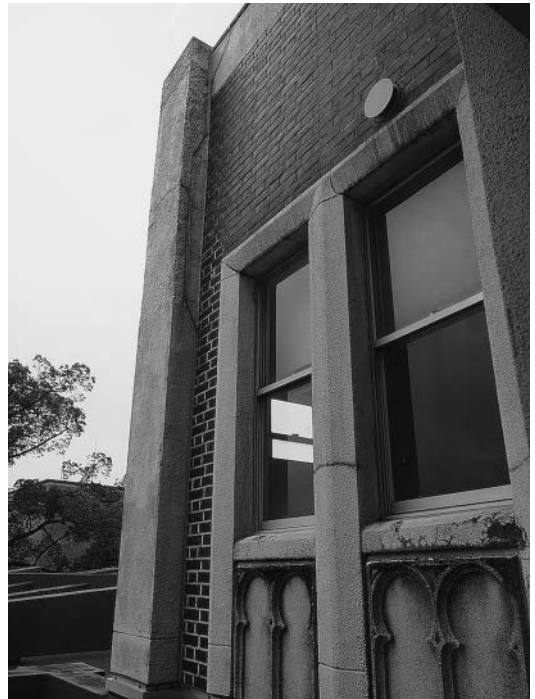
旧図書館と円形図書館との接合部分 (外観の塔屋部分)
