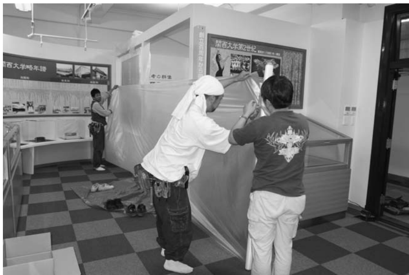
常設展示室の工事風景
