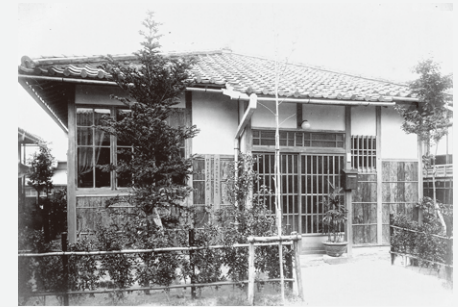
*千里山住宅地内 日本式住宅 1923年ごろ
