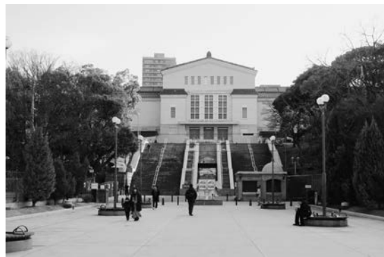
大阪市立美術館 現況 「アヴェニュー」は天王寺動物園上に架かる幅広の陸橋となり、美術館玄関前の階段は少し短くなった。
