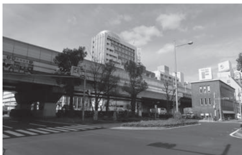
旧四ツ橋所在地 現況
