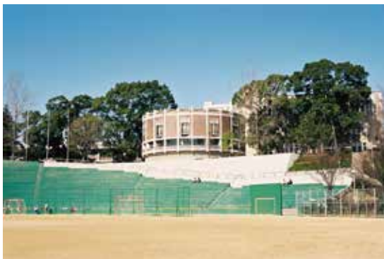
図 16 グラウンドから見た簡文館（1955）
