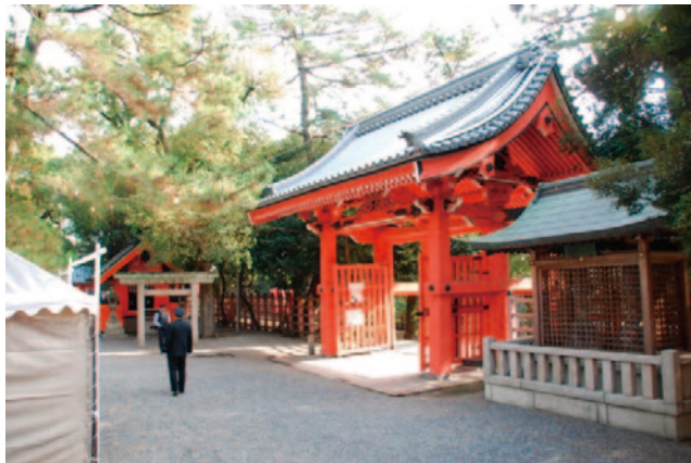
若宮八幡宮と南中門（現況）
