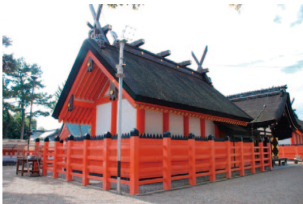
第一本宮本殿（現況）
