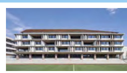
関大一高新校舎「黎明館」の外観
