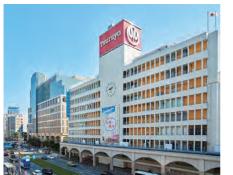
▲鶴屋百貨店 本館外観。左奥は東館
