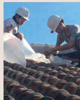
▲屋根瓦の調査を行う研究室の学生 Research laboratory students investigating roof tiles
