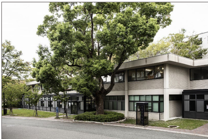
< 現・誠之館 2 号館（解体予定） >
