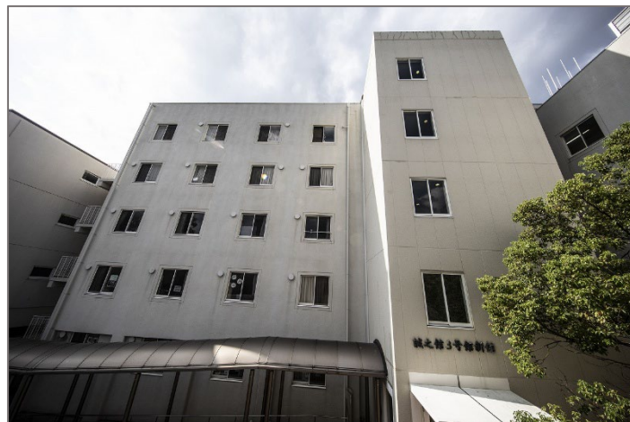
< 現・誠之館 3 号館（解体予定） >
