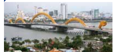
ベトナム ダナン市のロン橋(ドラゴン橋)
