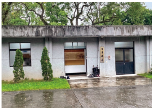
写真4: 軍事法廷の外観
