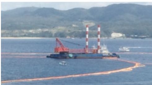
大浦湾のフロートとクレーン台船
