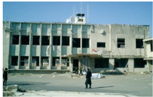
被災した大槌町役場
