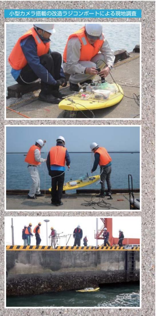
小型カメラ搭載の改造ラジコンボートによる現地調査
