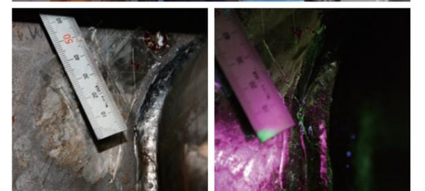
橋桁切欠き部の疲労亀裂
