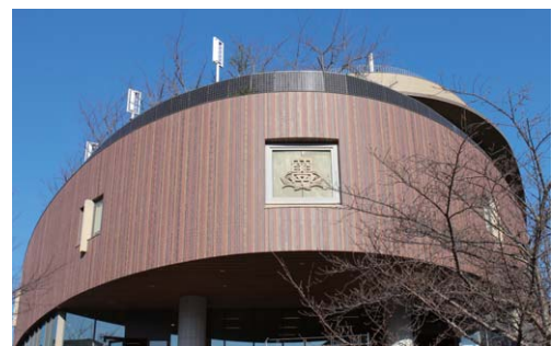
凧風館の太陽電池モジュールパネル
