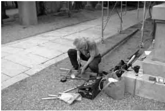
写真 1-5 鳥居の石柱に渡す竹を加工中 (妻木靖延)。
