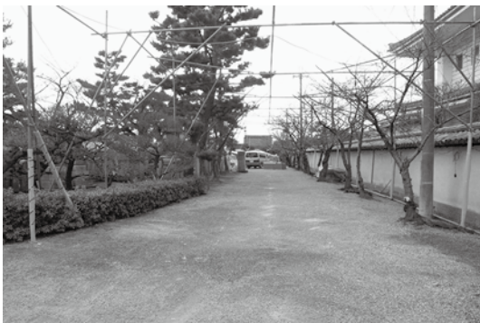
写真 1-15 単管フレーム設置風景
