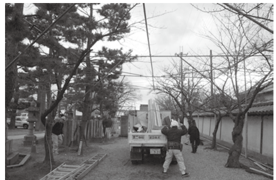
写真 1-16 単管フレーム設置風景
