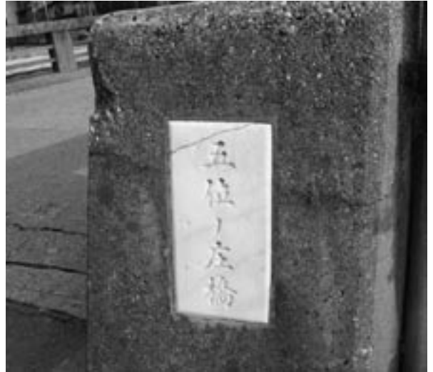
高槻市芝生・唐崎北に架かる五位ノ庄橋
