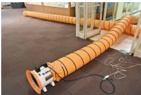
写真1 送風機とダクトを用いた換気作業
