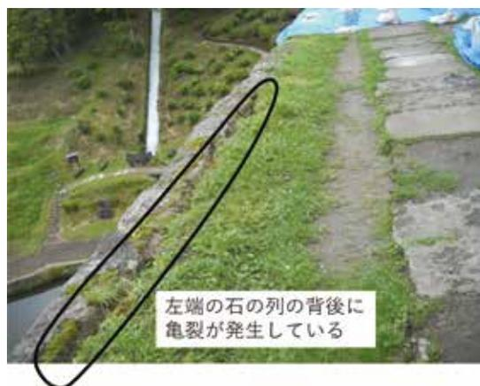
写真3 地震により生じた地表面の亀裂
