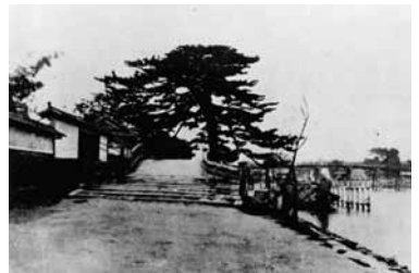
写真6 蛸の松と玉江橋
