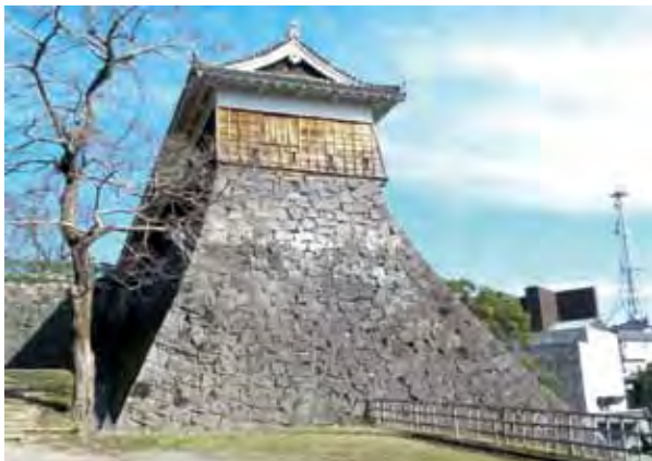
写真7 熊本城東十八間櫓（重要文化財）
