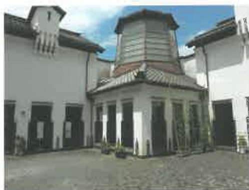
中庭から見たエントランスホール
