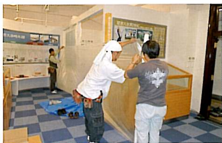
改修工事が進む常設展示室
