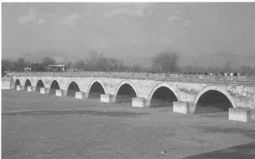
写真② 盧溝橋全景
