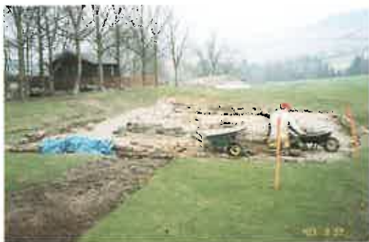
遺構を整備している様子
