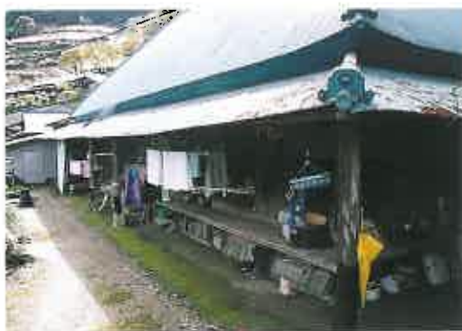
写真1 雨垂れ落ちと広い軒下をもつ住まい ——東祖谷山村中上、西岡家
