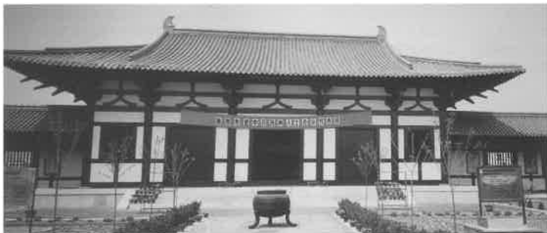
完成近い鑑真渡航記念館
