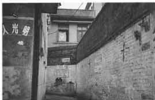
旧温州開元寺の外壁
