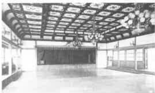
威徳館の内部
