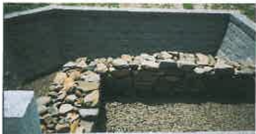
写真② オランダ商館石造倉庫の基礎部分
