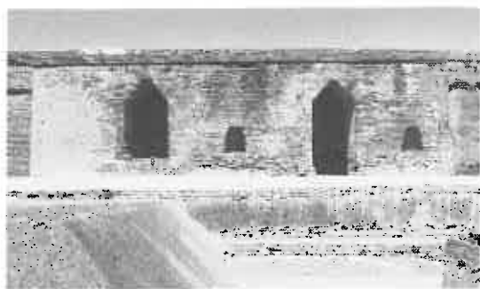
写真2 サルナート遺跡の煉瓦造遺構
