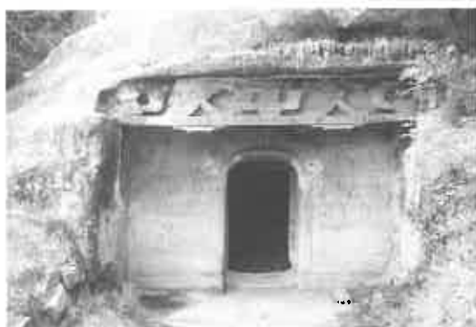
写真1 天竜山石窟(北斎時代550~580年の開削と推定)の皿斗と人字割束
