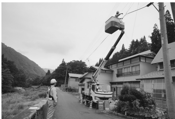
図 12 光ファイバー工事
