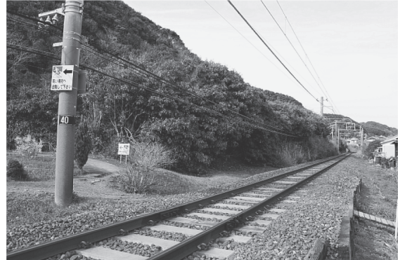
図5 「高い場所へ避難して下さい」と表示された線路外出口標および自治体が線路外に設置した避難場所への誘導標識(串本駅付近)
