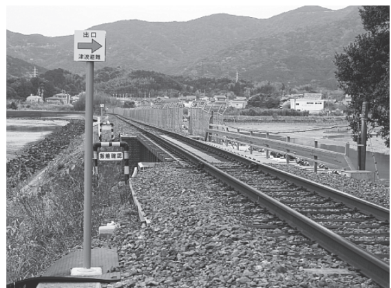
図8 JR 東海の線路外への誘導標識（参宮線、池の浦シーサイド・鳥羽間）
