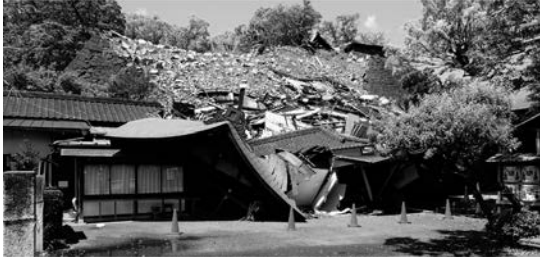
図6 東十八間櫓の被災状況
