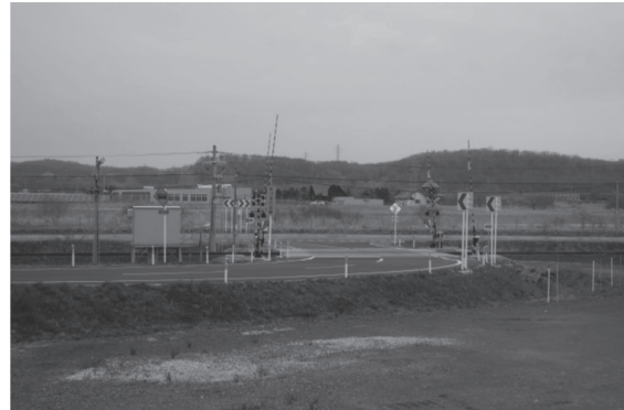
図8 白糠町に新設された恋問踏切
